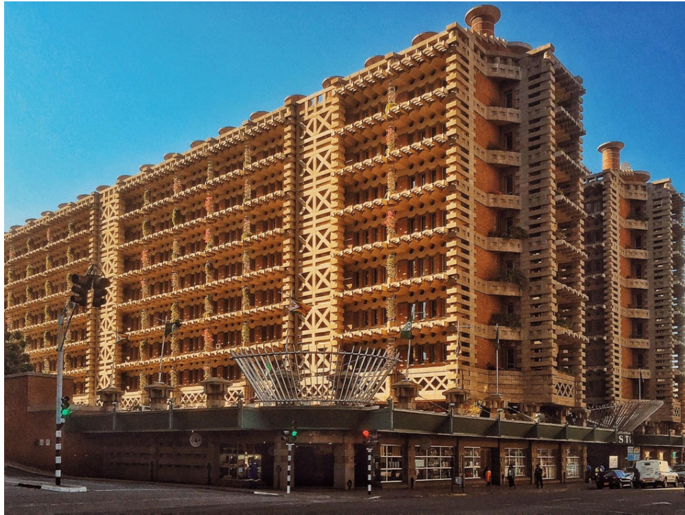
Fig. 55 The Eastgate Center de Mick Pearce à Harare, Zimbabwe qui utilise le principe de refroidissement de la termitière.
