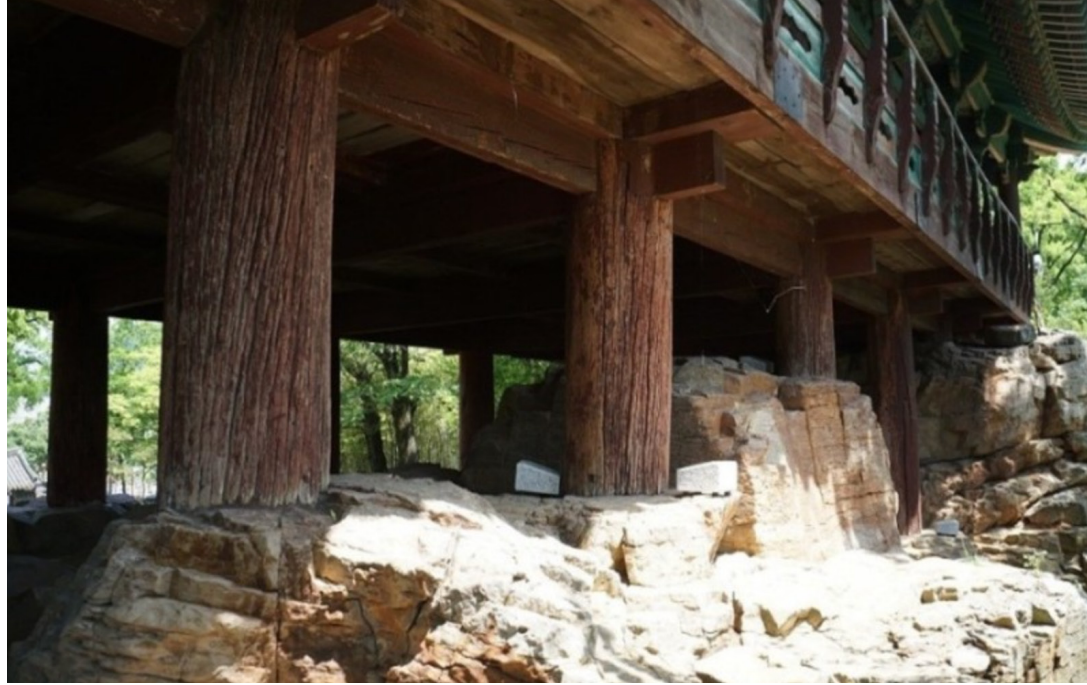
Fig. 52 Dumbung piédestal de Jukseoru Pavillon, Corée du Sud Le pavillon a été posé sur la pierre sans toucher le sol.
