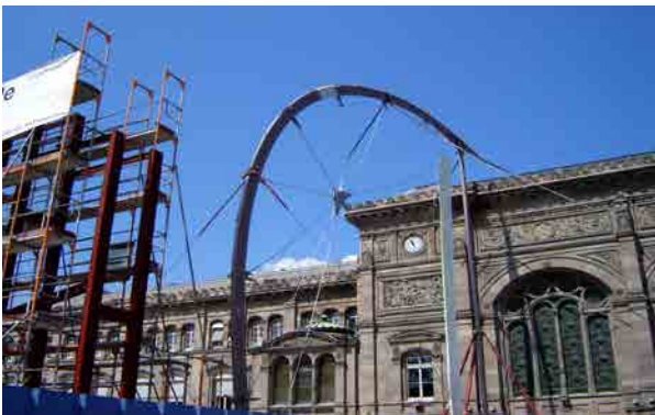
Travaux pour la nouvelle gare de Strasbourg
