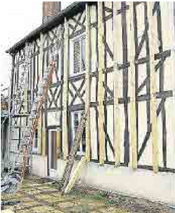
Travaux d'isolation extérieure sur une maison de Tourville-la-Campagne dans l'Eure : avant © Journal, Le Figaro
