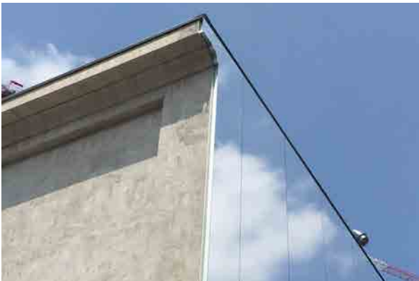
Jonction béton/miroir, Fondation Prada, Milan
