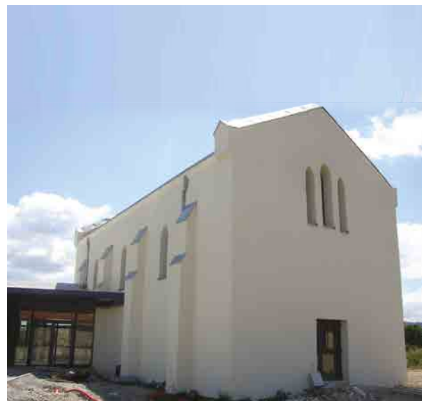
Travaux d'isolation extérieure sur une chapelle dans la Loire : après
