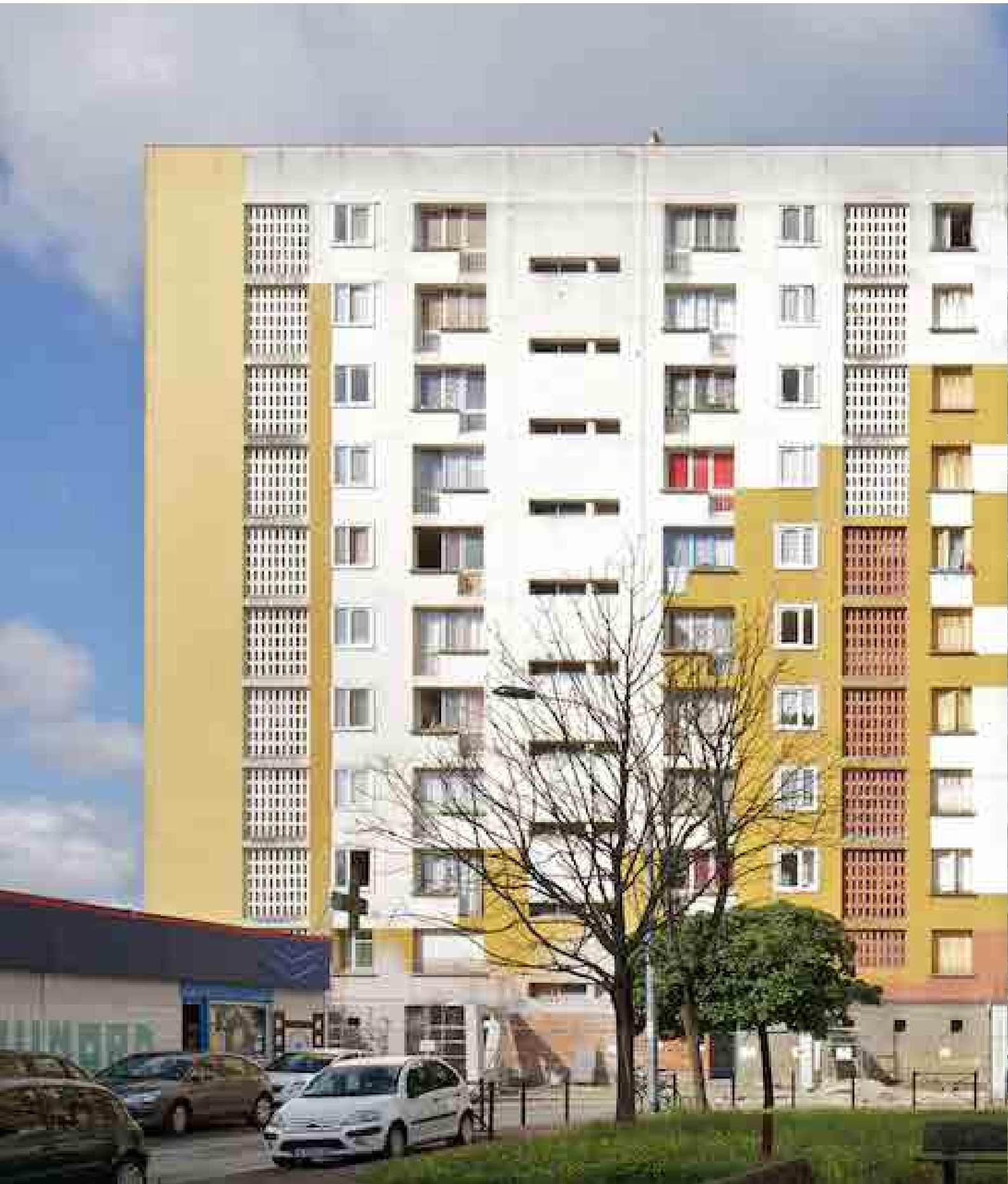
Cité du grand parc à Bordeaux – 530 habitations : avant
