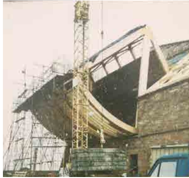
Château du Lichtenberg pendant travaux © Château du Lichtenberg
