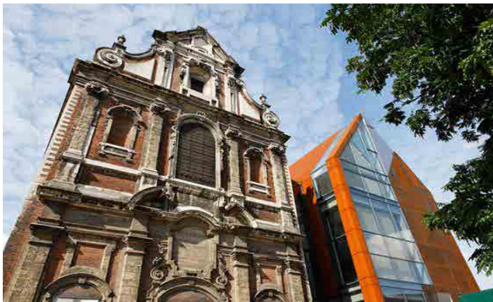
Les Brigittines, façades avant
