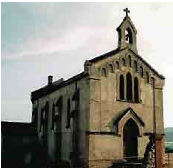
Travaux d'isolation extérieure sur une chapelle dans la Loire : avant
