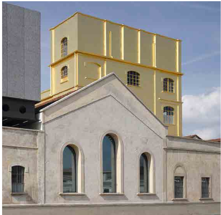
Mur d'enceinte, Fondazione Prada, Milan © Bas Princen
