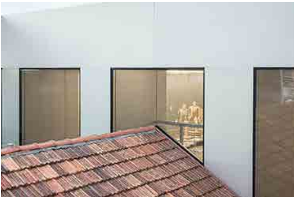
Conflit toiture fenêtre, Fondation Prada, Milan © Bas Princen
