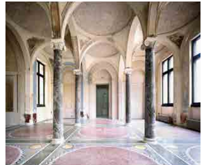
Travaux de restauration de l'aile gauche en cours © David Chipperfield
