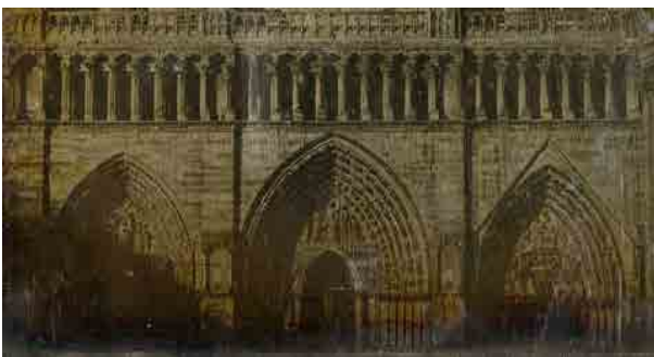
Façade occidentale de la cathédrale avant restauration
