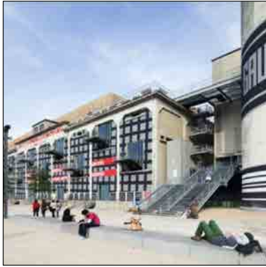
Usine de sucre
