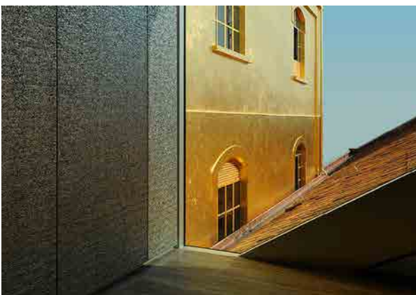
conflit toiture fenêtre, reflets dorés, Fondation Prada, Milan
