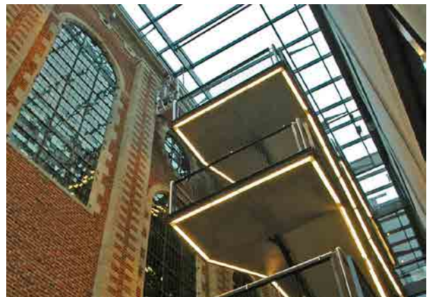
Les Brigittines, escalier, liaison entre l'ancienne et la nouvelle structure
