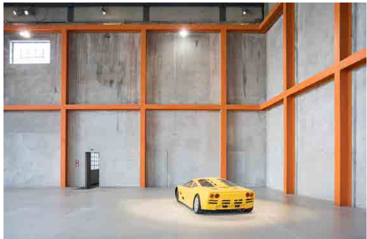
Intérieur : Trame orange, nouvelles poutres acier, Fondazione Prada, Milan © Simón García arqfoto
