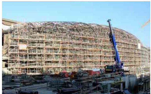
Travaux pour la nouvelle gare de Strasbourg
