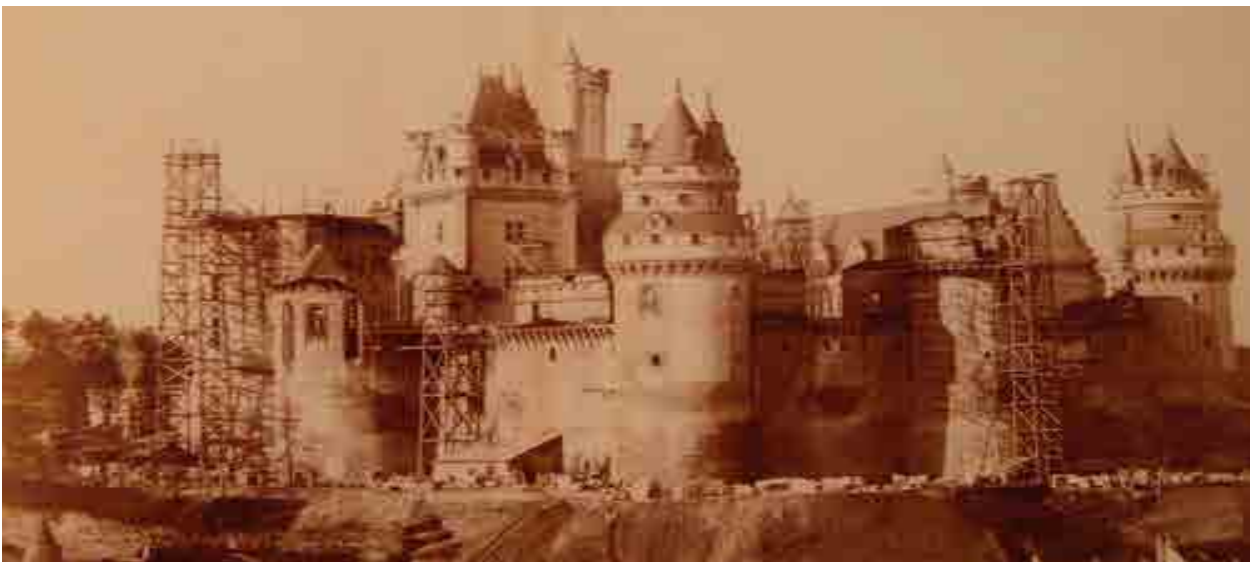
Château de Pierrefonds en cours de restauration
