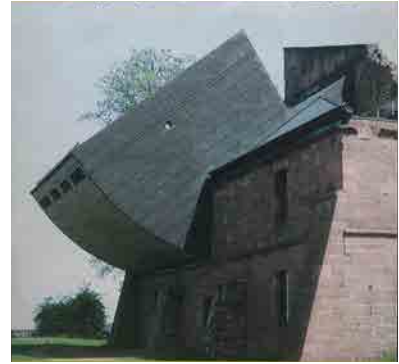
Château du Lichtenberg après travaux © Château du Lichtenberg
