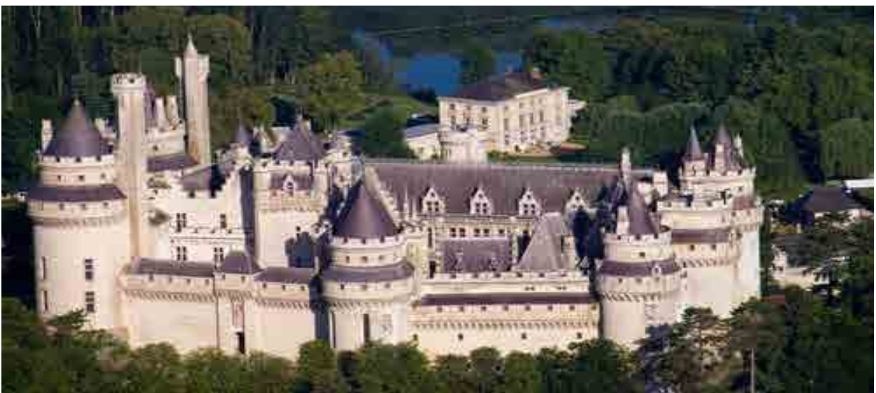
Château de Pierrefonds restauré par Viollet-le-Duc
