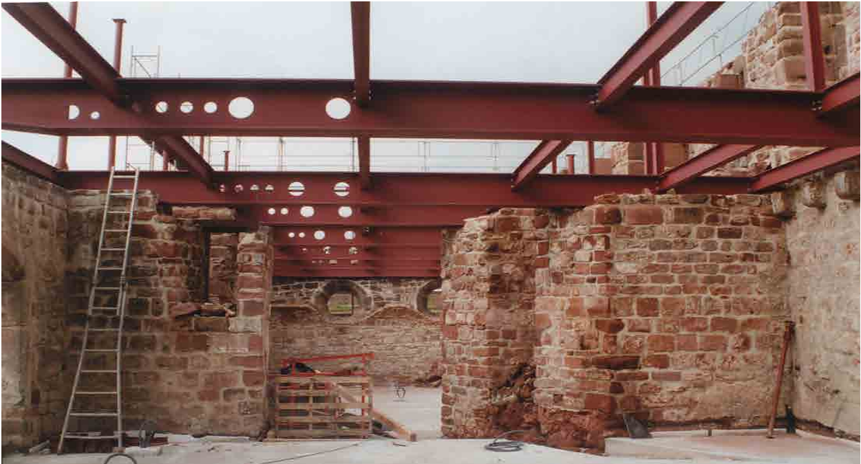
Château du Lichtenberg pendant travaux, structure autoportante © Equipage architecture
