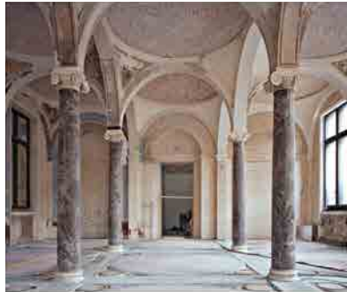
Travaux de restauration de l'aile gauche en cours © David Chipperfield
