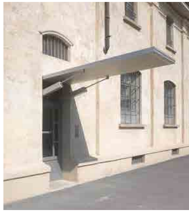
Détail ouverture de porte, Fondation Prada, Milan
