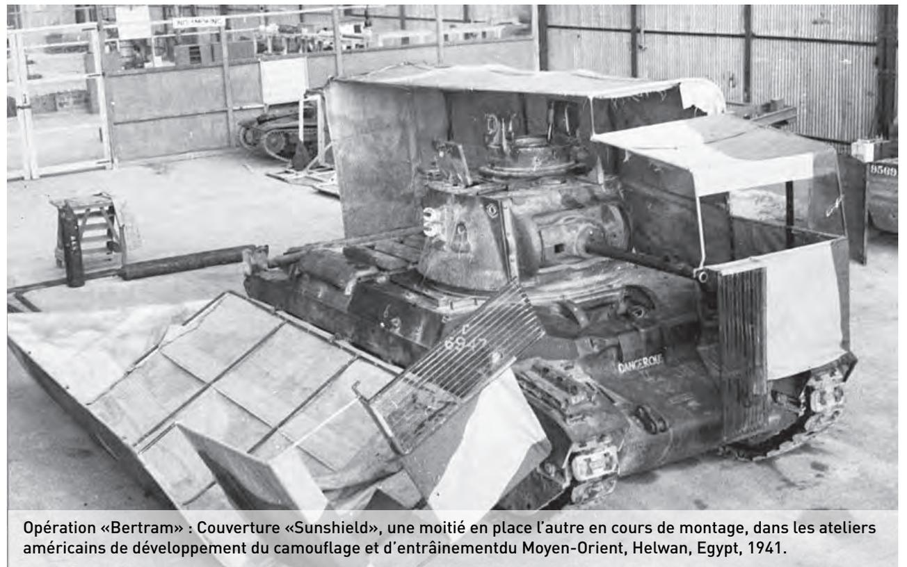
Opération «Bertram» : Couverture «Sunshield», une moitié en place l'autre en cours de montage, dans les ateliers américains de développement du camouflage et d'entraînement du Moyen-Orient, Helwan, Egypt, 1941.
