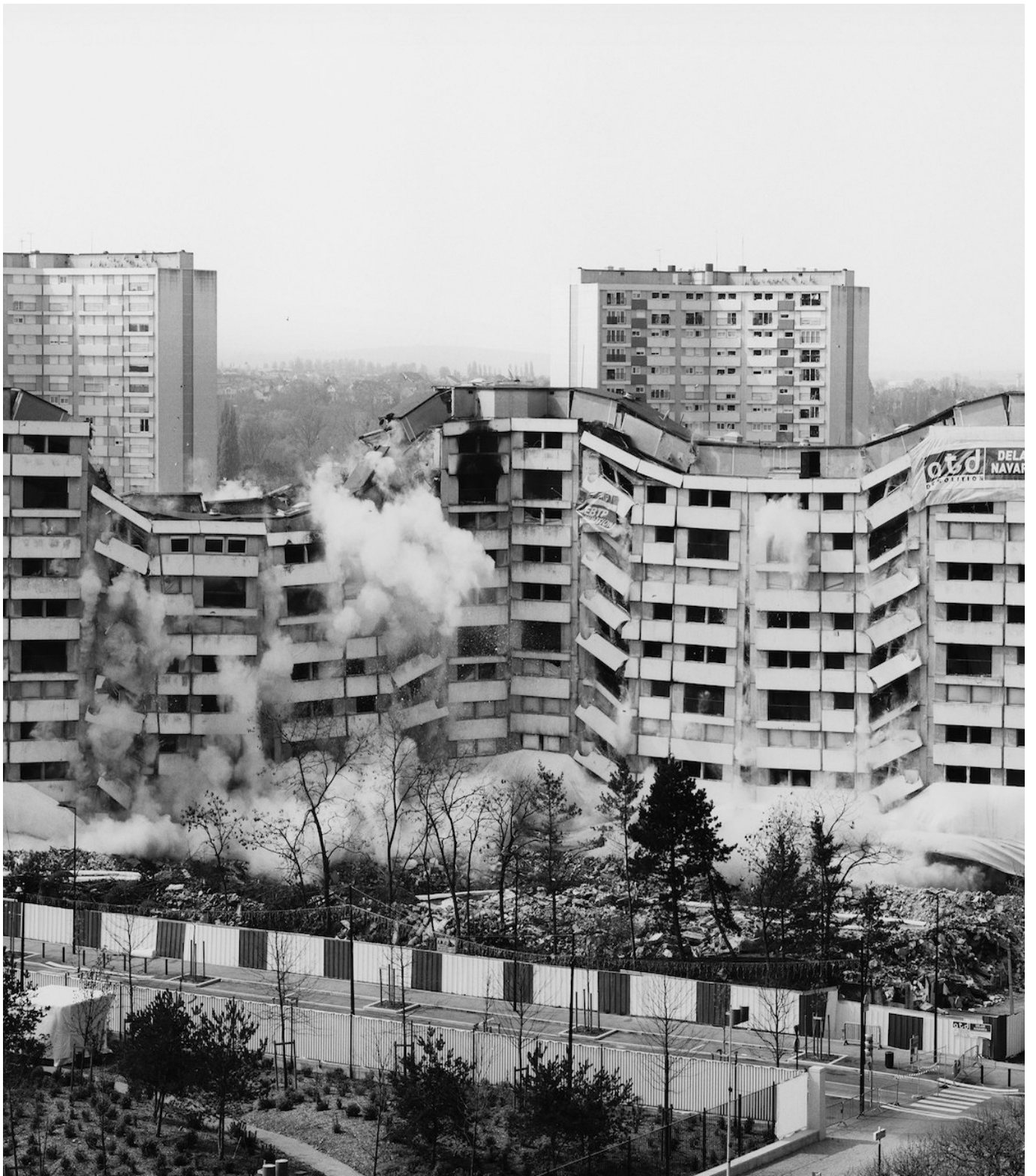
Démolition d'une barre de la cité de Meaux le 17 avril 2005 © Mathieu Pernot 2005
